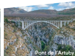
Pont de l'Artuby
